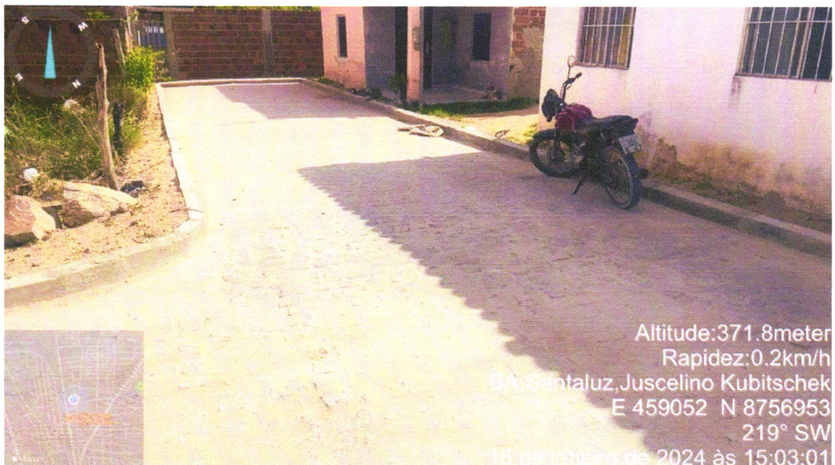
Execução de pavimentação Rua José Aristide Monteiro (Trecho III)
